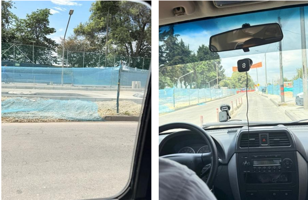
Figura 12. Registro fotográfico Carrera 111 hasta la Carrera 114
