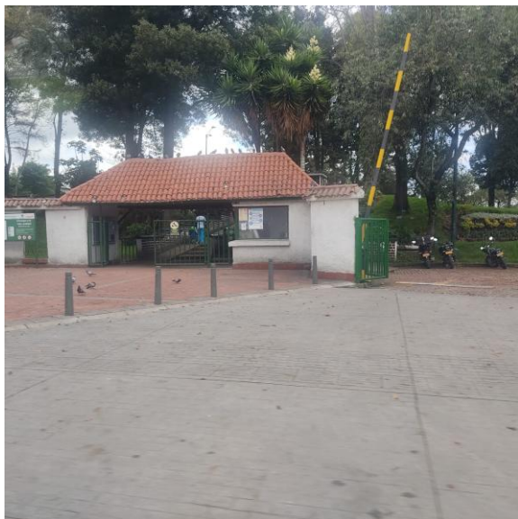
Figura 9. Registro fotográfico Parque de los Novios
