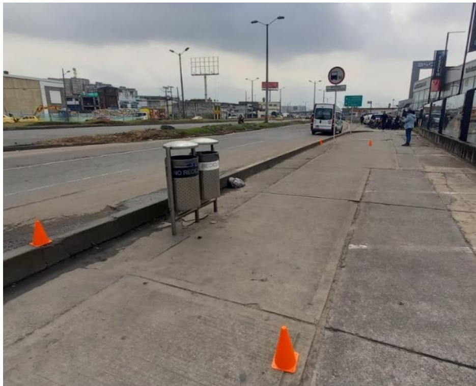
Figura 57. Paradero del corredor de la Calle 13 - Av. Las Américas identificado con ID N134
