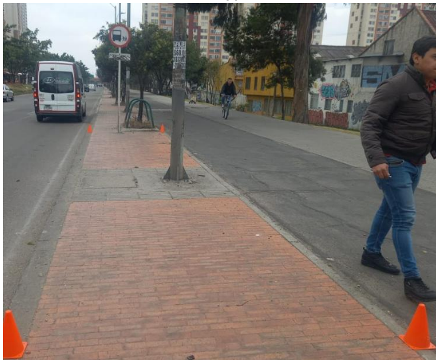
Figura 50. Paradero del corredor Soacha – Bogotá R3 Teusaquillo identificado con ID N100
