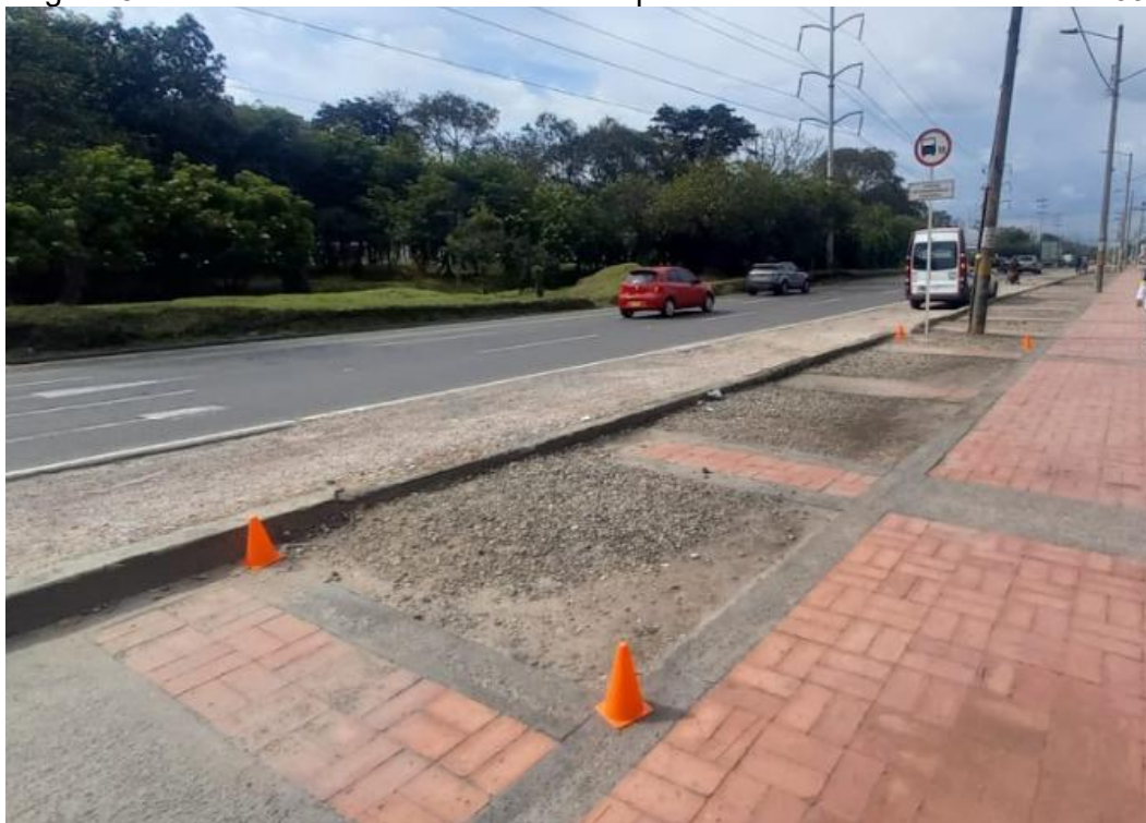
Figura 82. Paradero del corredor de la Autopista Norte identificado con ID N169
