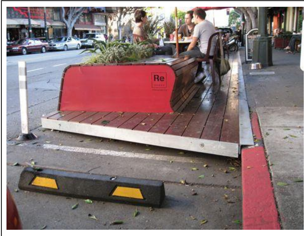
Ilustración 2. Elemento de protección del Parklet
