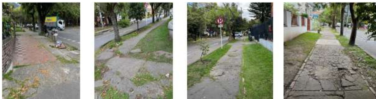
Imagen 21. Estado espacio público BV
